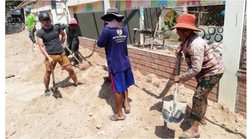
b 公立小学校改修ボランティア参加の様子
